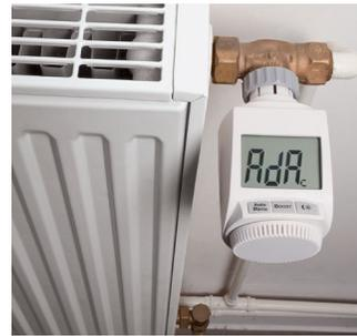
**Bild 9:** Drücken Sie nun die Boost-Taste. Der Thermostat beginnt mit einer Adaptierfahrt und stellt sich auf das Heizkörperventil ein. Der Heizkörperventil ist nun einsetzbar für den manuellen Betrieb.
