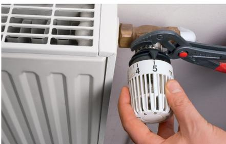
**Bild 5:** Drehen Sie den mechanischen Thermostat voll auf und drehen Sie die Überwurfmutter gegen den Uhrzeigersinn, dann nehmen Sie den Thermostat ab. Je nach Ventil kann die Demontage variieren. Details dazu finden Sie in der MAX!-Bedienungsanleitung.
