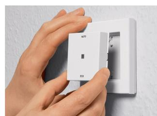
**Bild 15:** Stecken Sie den Taster auf die Montageplatte. Denken Sie dabei an den Rahmen.
