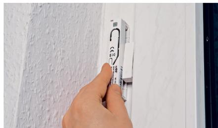
**Bild 11:** Montieren Sie beide Einheiten an den Fensterrahmen per Klebestreifen oder Schraubbefestigung. Beachten Sie, dass der Abstand zwischen beiden Einheiten nicht größer als 8 mm ist.
