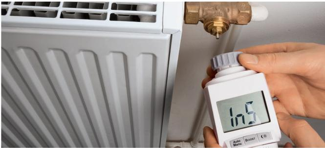
**Bild 8:** Sobald im Display „InS“ steht, können Sie den Thermostat auf das Heizkörperventil aufschrauben. Ziehen Sie die Überwurfmutter nur handfest an. Je nach Ventil müssen Sie ggf. einen der mitgelieferten Adapter einsetzen. Details dazu finden Sie in der Bedienungsanleitung.
